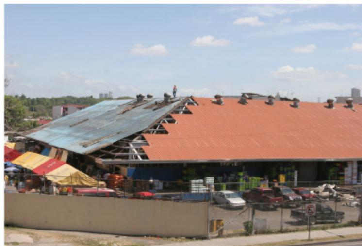
*El Edificio 0640 del Mercado de Abastos fue remodelado con la instalación del techo nuevo, remoción del cielo raso, construcción de rampas para discapacitados, restauración de estructuras, cambio y reparación de mallas, pisos, iluminación y habilitación de medidores.*
